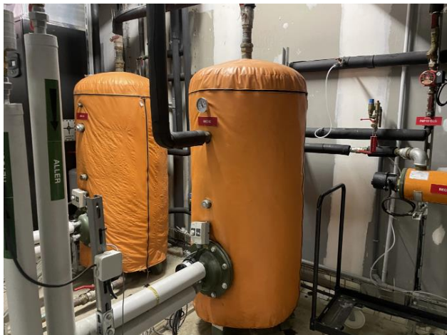
Installation ECS existante à déposer
